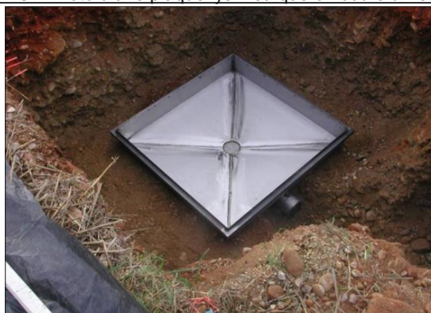
Figure 13 - Photo d'une plaque lysimétrique en cours d'installation
